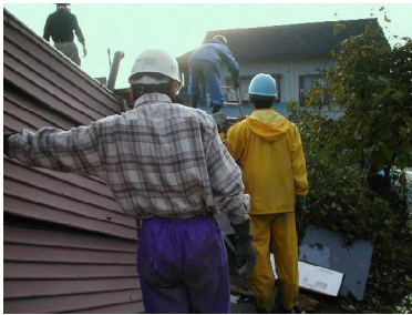
瓦を1列になって屋根から撤去
